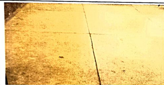
Foto 3: sustitución de piso rústico por cerámico en dos aulas
